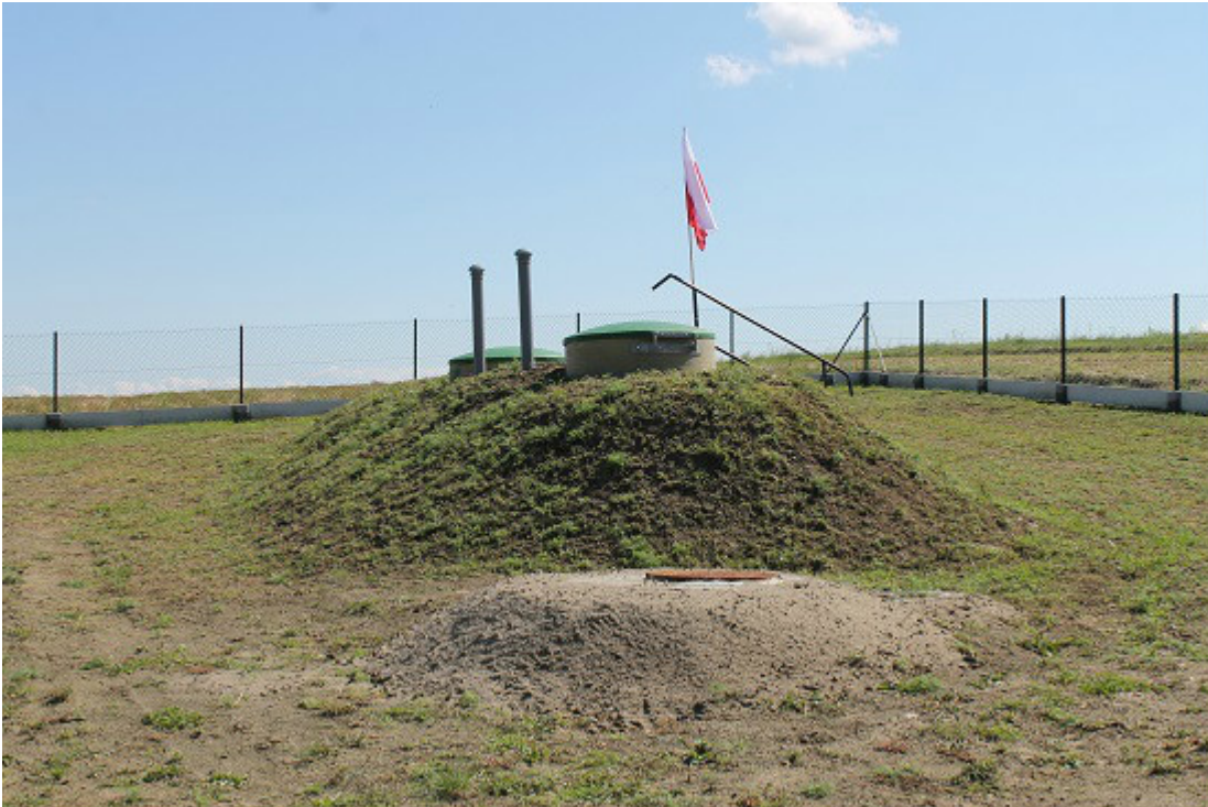
Zbiornik wody Golcowa V-50m3
